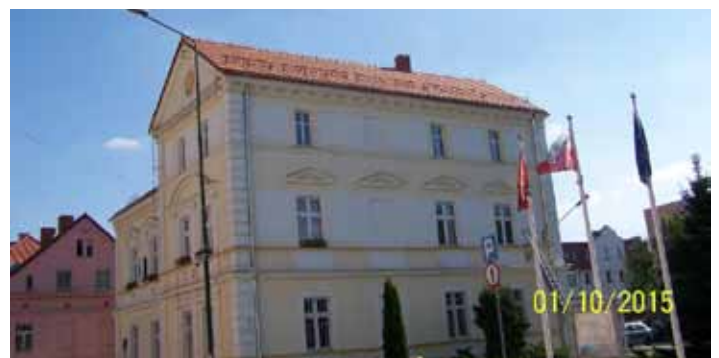
ul. Piastowska 29 – stan po zakończeniu inwestycji
