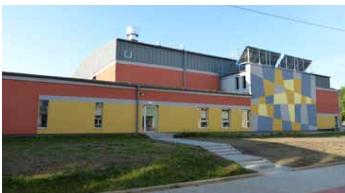
Hala sportowa przy budynku Szkoły Podstawowej
