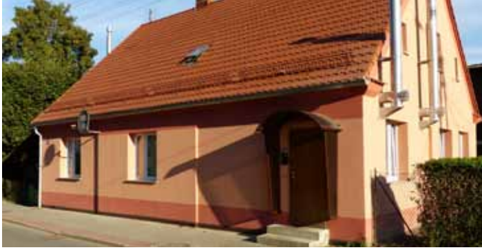
remont elewacji i dachu ul. Sienkiewicza 20
