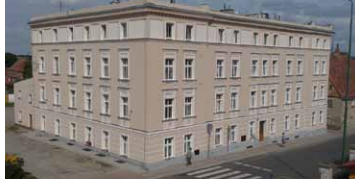
remont elewacji ul. Piastowska 82
