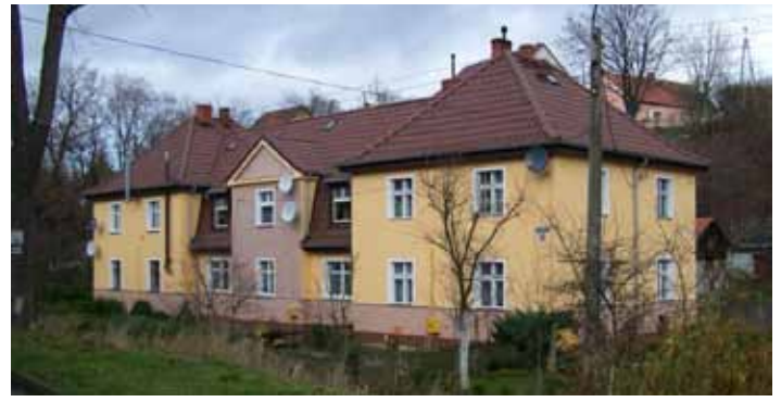
remont elewacji ul. Sienkiewicza 88
