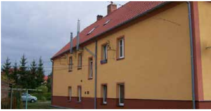
remont elewacji ul. Wąska 4
