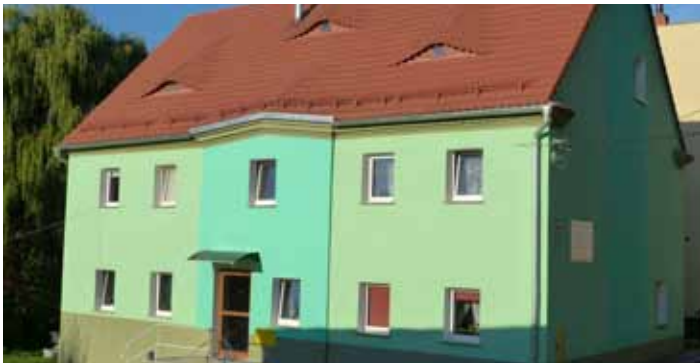
remont elewacji i dachu ul. Sienkiewicza 17
