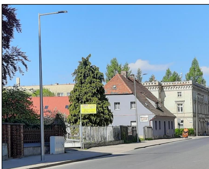
Energooszczędne oświetlenie uliczne
