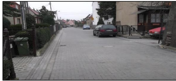
Przebudowa drogi gminnej osiedle Młyńskie
