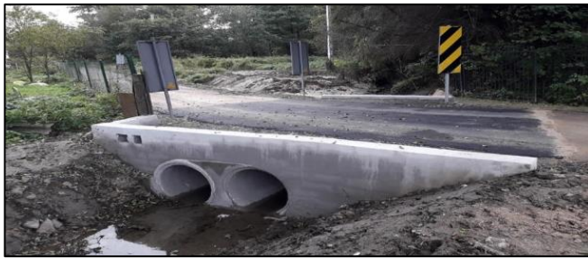
Przepust drogowy ul. Partyzantów
